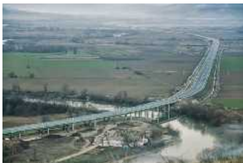
Fig. 8. VTR ® Mure Viaduct (2012)
